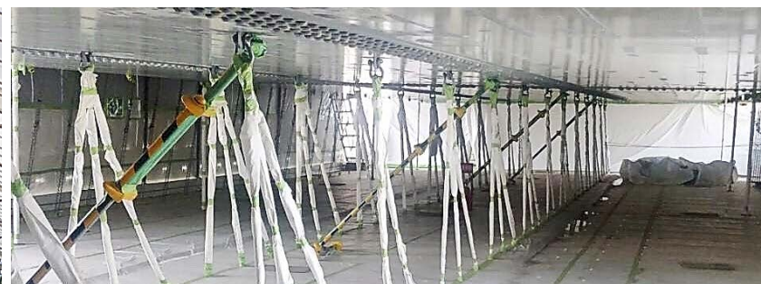
橋梁塗装工事 養生シート(スーパーライト防災クロス)
