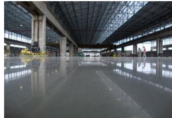
◆ バルチップ（無鉄筋土間工法）
