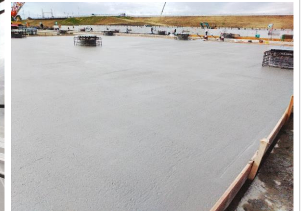
バルチップ施工例
