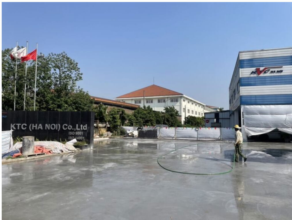
ベトナム ハノイでの工場建設現場の施工の様子
