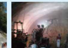
トンネル内壁への吹付
