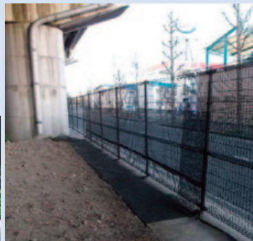
高強力ネットの施工例
