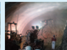
トンネル内壁への吹付
